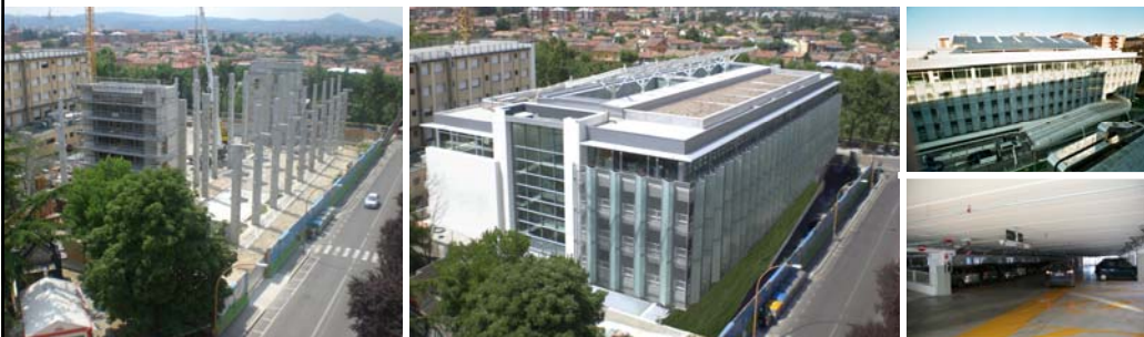
“ IV Novembre” Car Park Project
